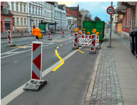
Sicherung eines Wechselbehälters wie eine Arbeitsstelle, wobei hier auch zu beachten ist, dass die Leitbaken hinter der Gelbmarkierung stehen müssen.
