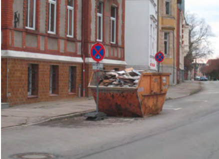
Negativbeispiel: Absicherung wie eine Arbeitsstelle? Sicherheitskennzeichnung? Foto: Langer, BG BAU
