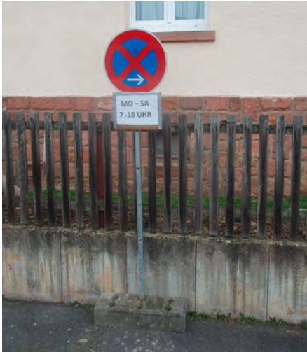
Die Standsicherheit des Verkehrszeichens ist durch den „Bauzaunfuß“ nicht gewährleistet. Auch alles andere (Aufstellhöhe, Zusatzzeichen, etc.) ist mehr als fragwürdig. Foto: Haardt, BG BAU
