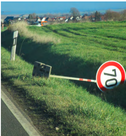
Wegen mangelhafter Standsicherheit (zu wenig Fußplatten) ist das Verkehrszeichen umgefallen. Foto: Haardt, BG BAU
