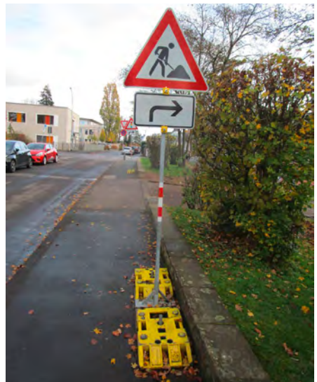
Standsicher aufgestelltes Verkehrszeichen Z123 „Arbeitsstelle“ mit Zusatzzeichen. Laut Berechnung wäre beim o.g. Beispiel die Standsicherheitsklasse K4 erforderlich. Aufgrund der örtlichen Gegebenheiten hat man sich dazu entschieden, einen Fußplattenträger einzusetzen, der bis zur Standsicherheitsklasse K6 (siehe Tabelle) ausgelegt ist. Foto: Haardt, BG BAU
