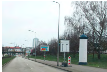
Einsatz eines Sperrpfostens auf dem Gehweg zum Kennzeichnen vom Verkehrszeichen mit verminderter Aufstellhöhe Foto: Langer, BG BAU
