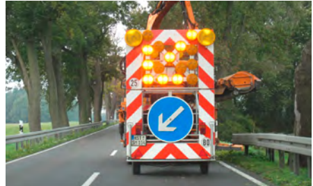
Straßenunterhaltungsmaßnahmen unter Verwendung einer fahrbaren Absperrtafel Z 616 Foto: Langer, BG BAU
