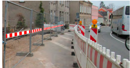
Kennzeichnung Bauzaun im Gehwegbereich mit 100 mm Absperrschranken
