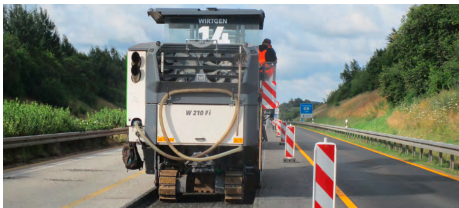
Fräsarbeiten Foto: Langer, BG BAU
