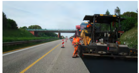
Asphalteinbau Foto: Langer, BG BAU
