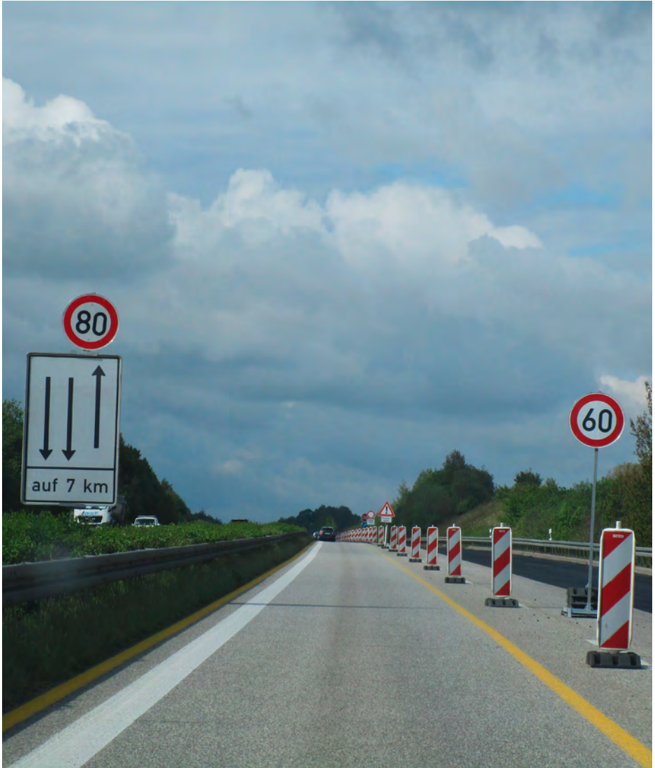
Einrichtung des Behelfsfahrtstreifens auf eingeschränkter Fahrbahn Foto: Langer, BG BAU
