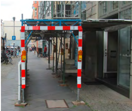
Absperrschranken 10 cm breit am Gerüst direkt montiert
