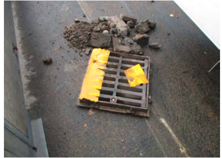
Ausbau eines Einlaufgitters im Bereich eines Straßenablaufs. Fotos: Haardt, BG BAU
